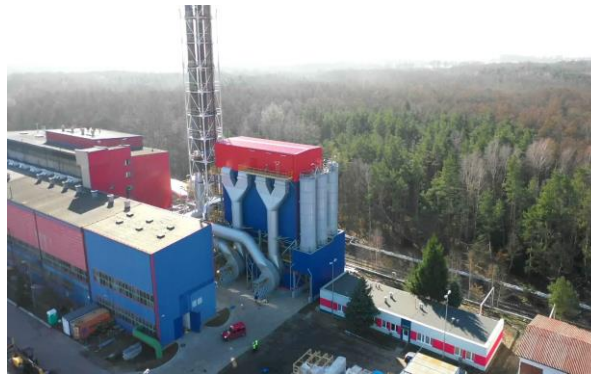
Instalacja Oczyszczania Spalin Elektrociepłownia w Lubinie
